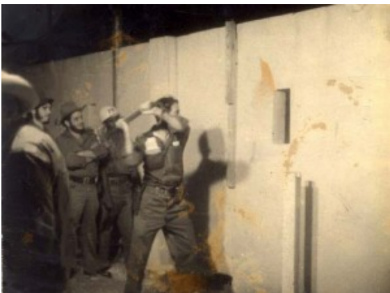
Camilo derrumbando el muro del Cuartel de Columbia
