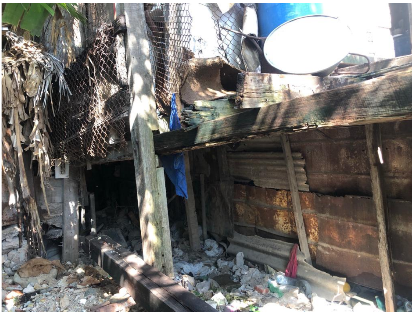
Pilotes sobre los que se asienta la “casa” (Foto de la autora)
