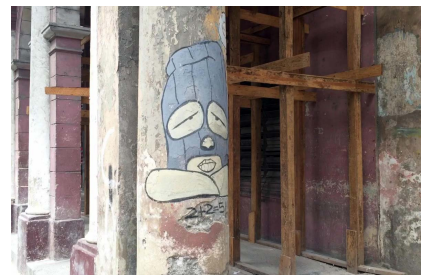
Fabián solo interviene espacios deteriorados, abandonados (foto del autor)
