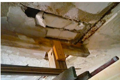
El techo agrietado, las vigas corroydas por el salitre
