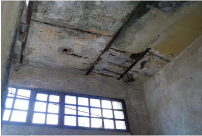
El techo agrietado, las vigas corroydas por el salitre
