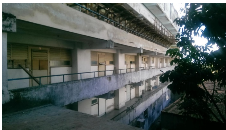
Ala de Julio trigo en Reparación (foto del autor)
