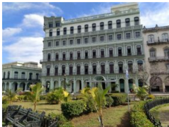
Hotel Saratoga antes de la tragedia (Foto de los autores)
